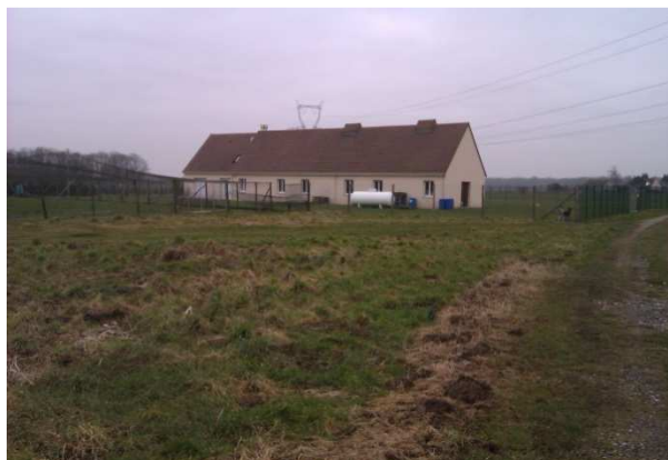
Maison avec cuve de gaz à pied à proximité du PPI du forage
