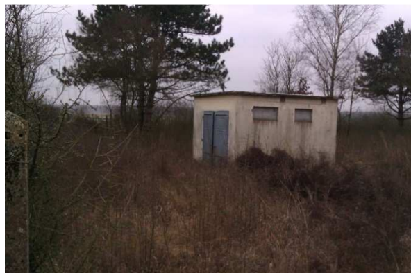
Ancienne station de pompage
